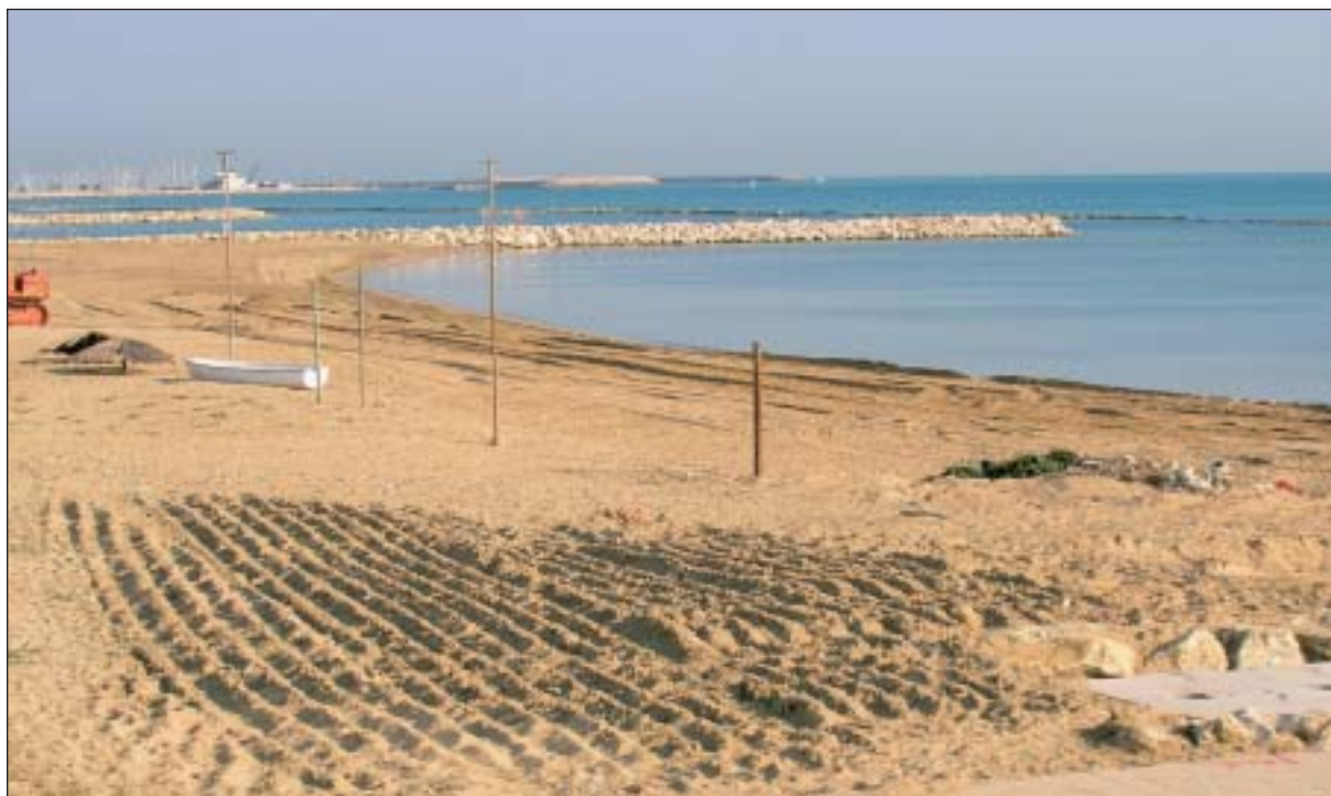
Spiaggia posta tra il porto di Pescara e Francavilla al Mare; sullo sfondo si osservano le opere di difesa costituite da un sistema di pennelli e barriere longitudinali, recentemente modificate (foto Maggio 2006).
