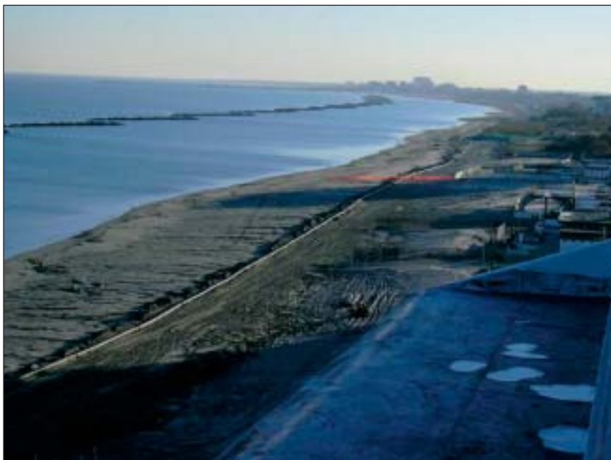
Fase del ripascimento effettuato sui litorali a settentrione di Porto Garibaldi utilizzando per il trasferimento delle sabbie un nuovo sistema di sabbiodotto.
