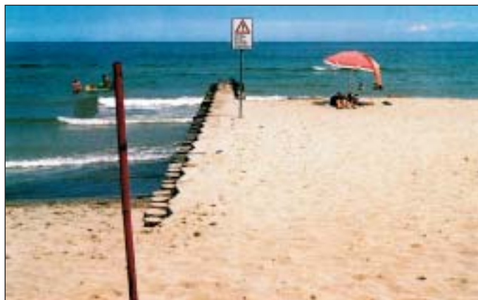
Fenomeni erosivi della spiaggia in prossimità della foce del Canale Bellocchio. Pennello in pali costruito nel tratto meridionale del litorale ferrarese.
