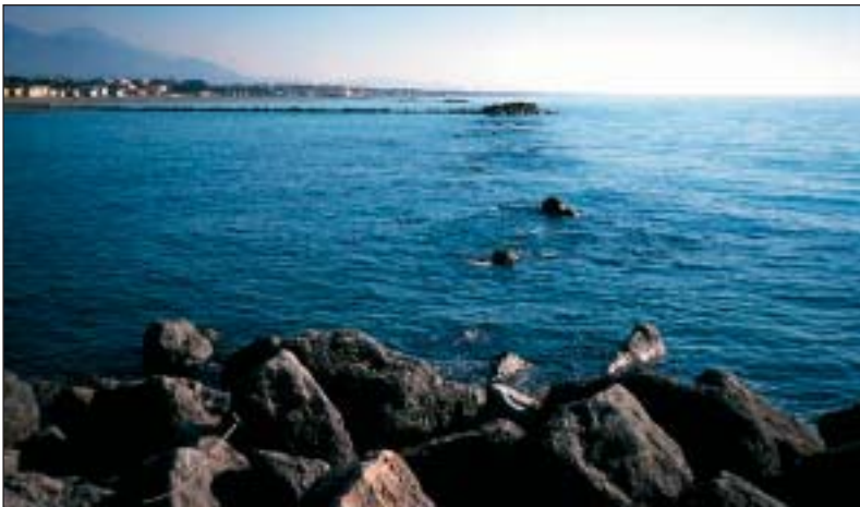
Il sistema di difese costiere di Marina di Massa (pennelli collegati all'estremità da una scogliera soffolta).
