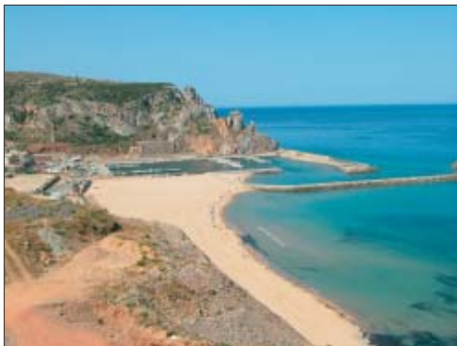
La spiaggia di Buggerru-Portixeddu (a sinistra) è battuta dai venti di maestrale e presentalocalizzati fenomeni di erosione che arrivano ad aggredire le dune retrostanti. I sedimenti in movimento verso sud vanno ad insabbiare il porto turistico di Buggerru (in alto), che rimane quindi inutilizzato.
