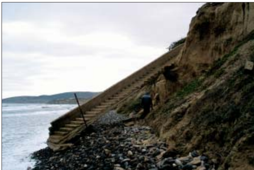
Spiaggia di Marritza (Sassari). L'effetto dell'arretramento della linea di riva nel corso degli ultimi anni.
