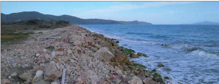
**Figura 14 - Vecchio argine di difesa della foce danneggiato per tracimazione ondosa (2006).**
