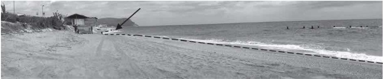
Figura 15. Opere distaccate sommerse (tipo “Ferran”); la freccia indica l’intensa erosione sottoflusso rispetto alle opere distaccate suddette.
