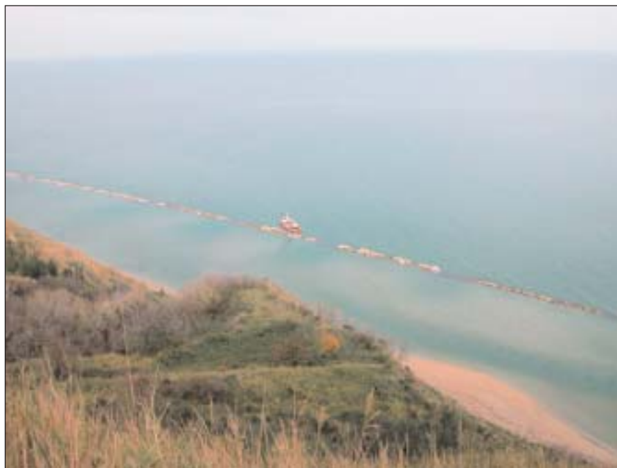
Monte San Bartolo: sviluppo della piccola spiaggia sabbiosa in seguito alla messa in posto delle scogliere.
