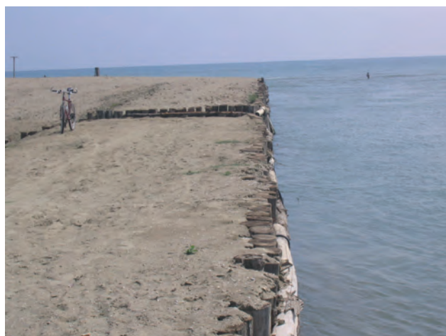
Figura 11 - Le opere di protezione della nuova foce e la gaveta appena completate. Vista da terra verso mare.
