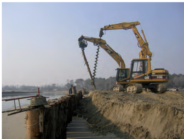
Figura 8 - La realizzazione della palificata in legno nella zona della nuova foce.
