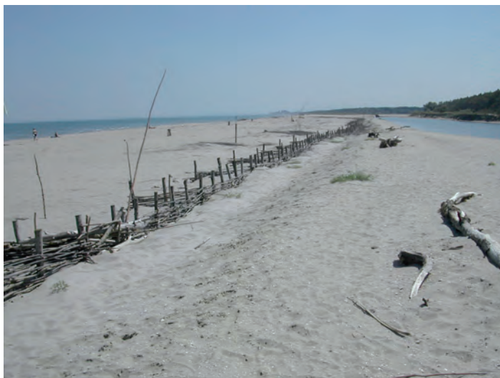
Figura 12 - La zona di duna ricostruita. Vista da nord verso sud. Alla destra il tratto di fiume abbandonato e alla sinistra il mare.
