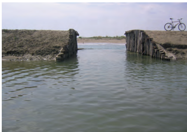
Figura 10 - La gaveta vista da dentro il tratto di fiume abbandonato.
