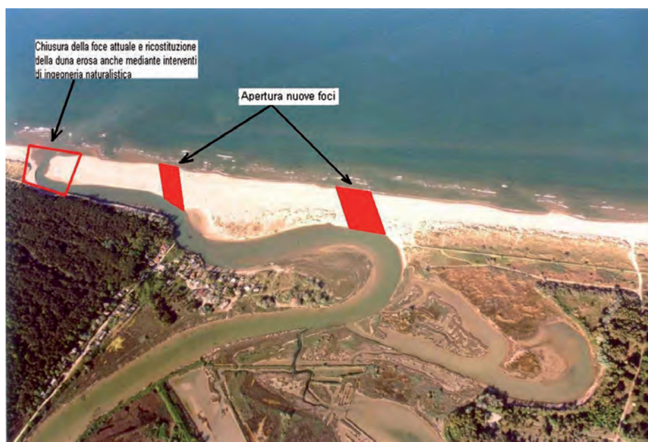
Figura 7 - La zona di foce prima dell'intervento, con individuate le zone interessate dai lavori.
