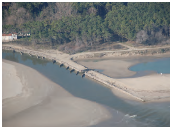
Figura 15 - Vista dall'alto della zona di foce nel 2008, con i repellenti già realizzati nel corso degli interventi di manutenzione (foto: Giovanni Gabbianelli - CIRSA, RA).
