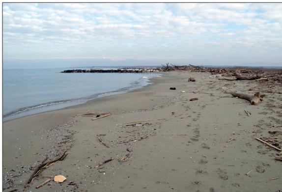
Figura 13 - Prima cella, in cui la densità di ripascimento è stata minore (alimentata con  $30 \text{ m}^3/\text{m}$ ) e dove in superficie è presente quasi sempre solamente la sabbia che si è depositata a fine versamento.
