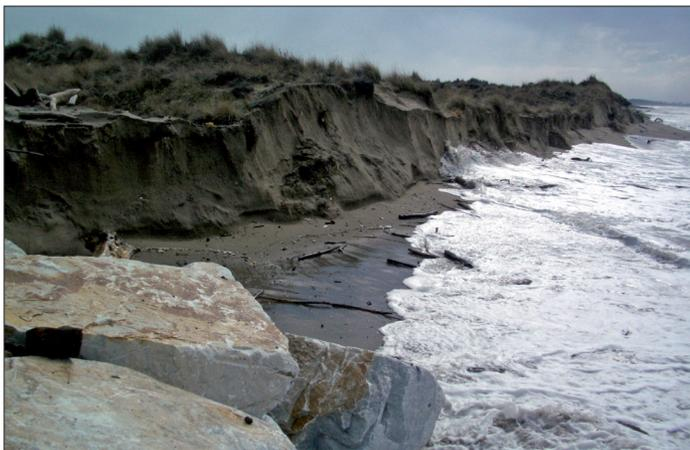
Figura 11 - Erosione della duna alla radice del molo guardiano della foce del Fiume Morto Nuovo. La struttura, invece che favorire la deposizione sul lato posto sopraflutto, determina la riflessione delle onde e l'erosione della spiaggia. In lontananza si vede una cuspide che si posiziona nel punto di convergenza fra il flusso sedimentario normale (diretto verso nord) e quello inverso generato dalla riflessione (diretto verso sud).
