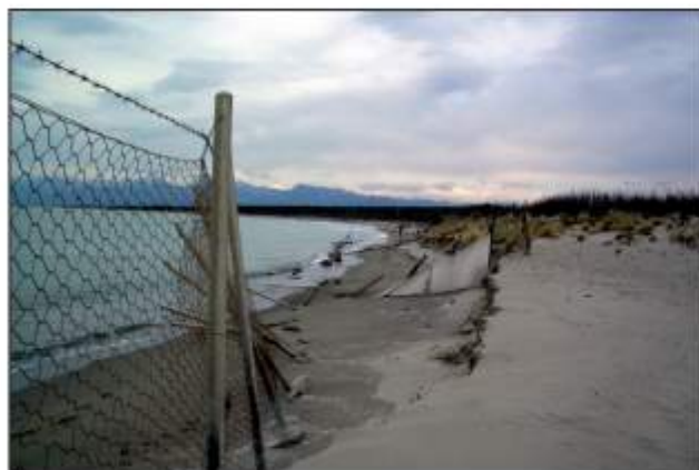
Figura 16 - Parte iniziale del tratto di litorale che collega il Gombo alla foce del Fiume Morto Nuovo: la recinzione che impedisce l'accesso alla Villa Presidenziale viene costantemente demolita nonostante che ogni volta venga ricostruita in posizione arretrata.
