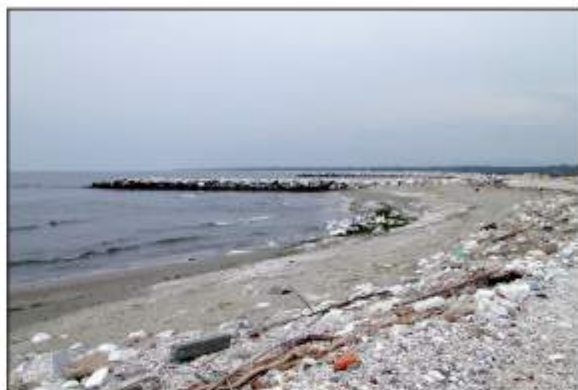
Figura 8 - Seconda cella con ripascimento in ghiaia nelle fasi di realizzazione (30 Ottobre 2001) e sei mesi dopo, a destra, quando parte della ghiaia è coperta dalla sabbia (24 Aprile 2002).
