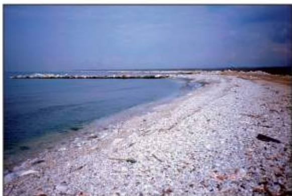
Figura 8 - Seconda cella con ripascimento in ghiaia nelle fasi di realizzazione (30 Ottobre 2001) e sei mesi dopo, a destra, quando parte della ghiaia è coperta dalla sabbia (24 Aprile 2002).
