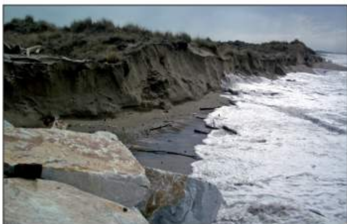
Figura 9 - Seconda cella dove la ghiaia forma un cordone che, in quasi tutte le condizioni meteomarine, impedisce la tracimazione (Foto del 31 1 2007).
