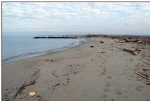
Figura 13 - Prima cella, in cui la densità di ripascimento è stata minore (alimentata con 30 m 3 /m) e dove in superficie è presente quasi sempre solamente la sabbia che si è depositata a fine versamento.
