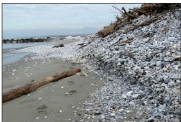
Figura 9 - Seconda cella dove la ghiaia forma un cordone che, in quasi tutte le condizioni meteomarine, impedisce la tracimazione (Foto del 31 1 2007).
